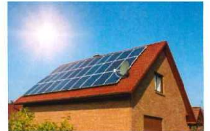
住宅用太陽光 発電システム
