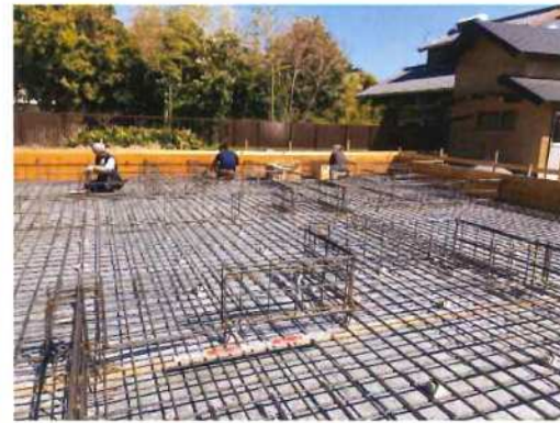
とび土工コンクリート工事 (基礎工事)
