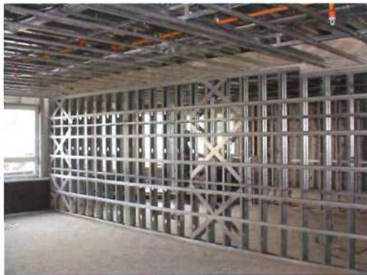
内装仕上工事 (軽鉄間仕切り工事)
