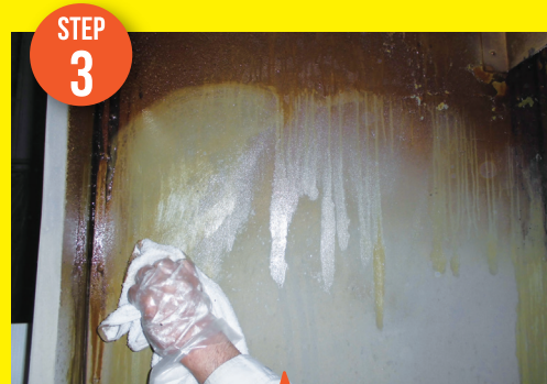
STEP 3 溶けたヤニをウエスで拭き取る
